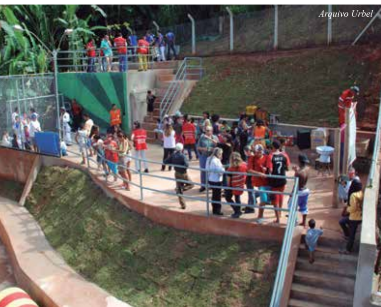
Pracinha construída pela Urbel no Aglomerado Cabana – antes, o lugar apresentava risco alto de deslizamentos e várias famílias foram removidas para a recuperação do local
