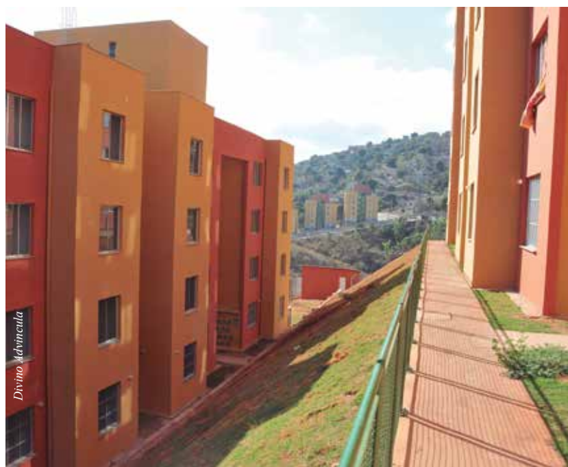
Prédios de apartamentos construídos para reassentamento de famílias removidas durante as intervenções do Vila Viva Taquaril
