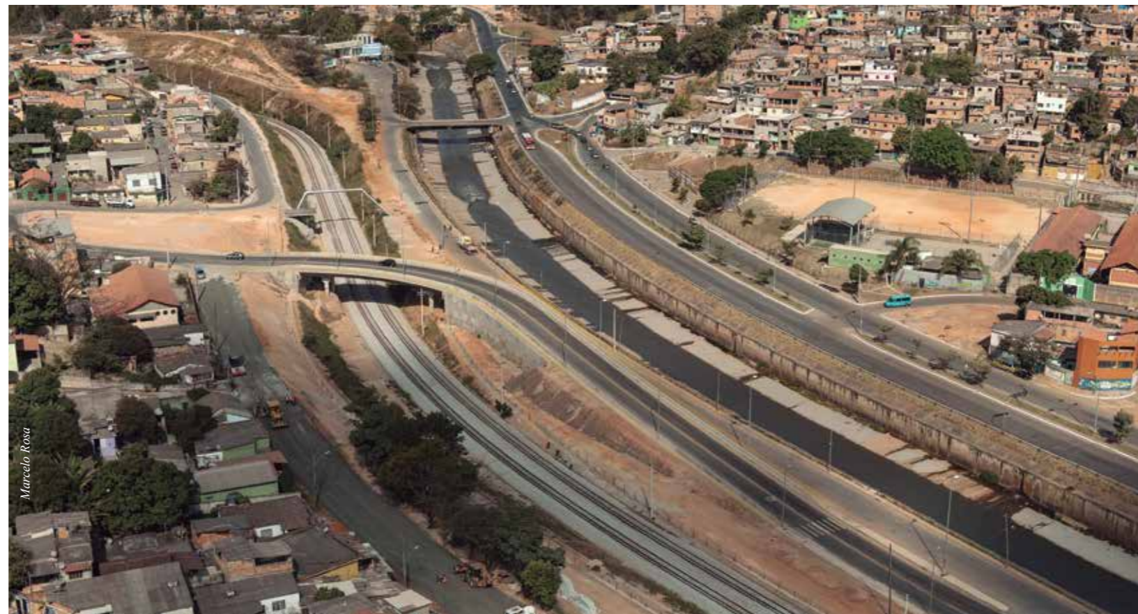
Viaduto rodoviário na Rua Burnier em substituição à passagem de nível para melhoria de segurança e fluidez no trânsito
