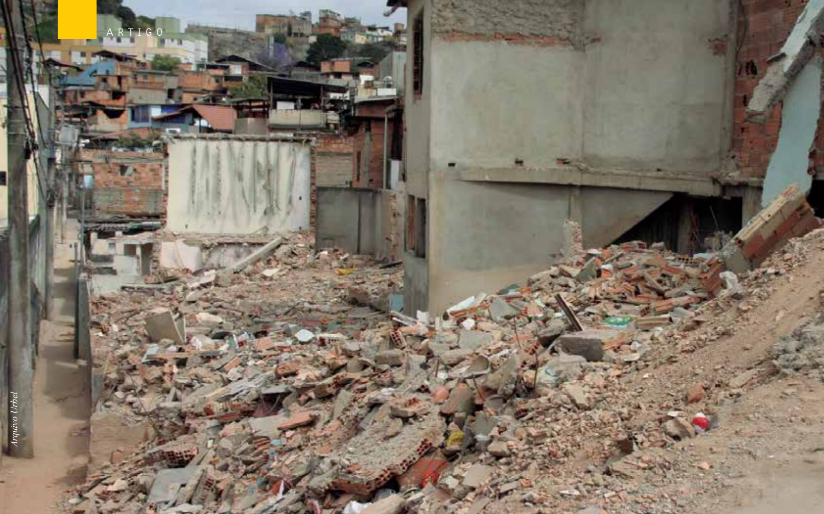
Demolição na Pedreira Prado Lopes
