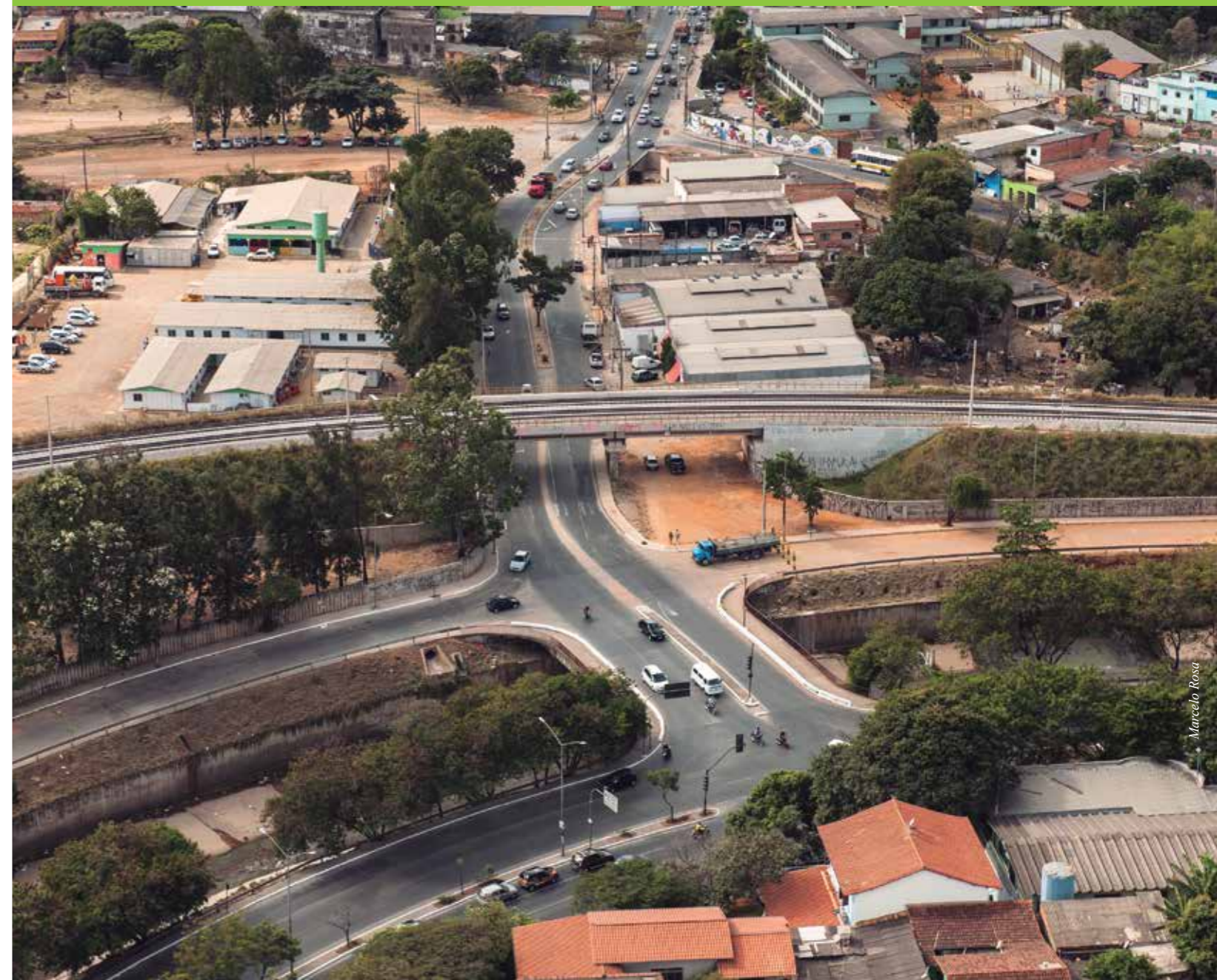
Viaduto ferroviário na Avenida Itaituba em substituição à passagem de nível para melhoria de segurança e fluidez no trânsito
