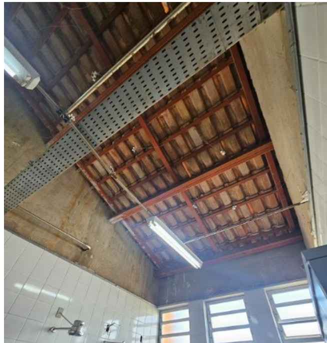
Figura 9: Local sem forro, expondo a estrutura existente do telhado
