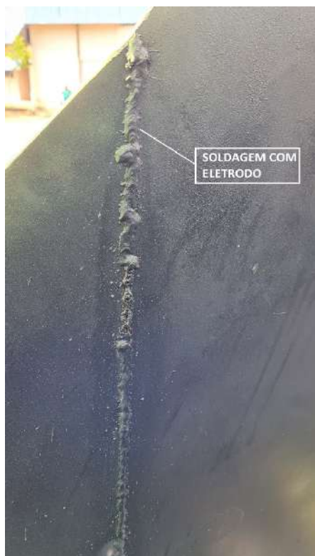
FOTO Nº 02 – soldagem com eletrodo
