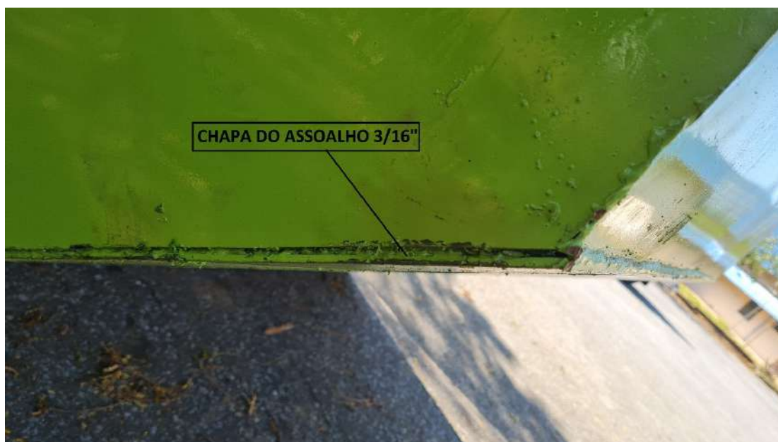
FOTO Nº 05 – chapa do assoalho 3/16”
