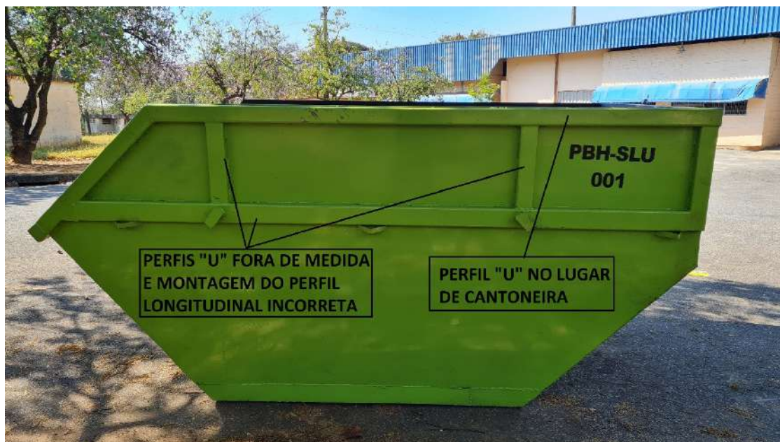
FOTO Nº 07 – perfis “U” inadequados e perfil longitudinal montado fora da posição correta. Uso de perfil “U” no lugar da cantoneira em desacordo com as especificações
