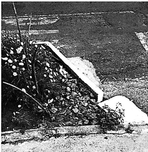
*Figura 8: dispositivo atenuador de vazão em jardim de chuva*
