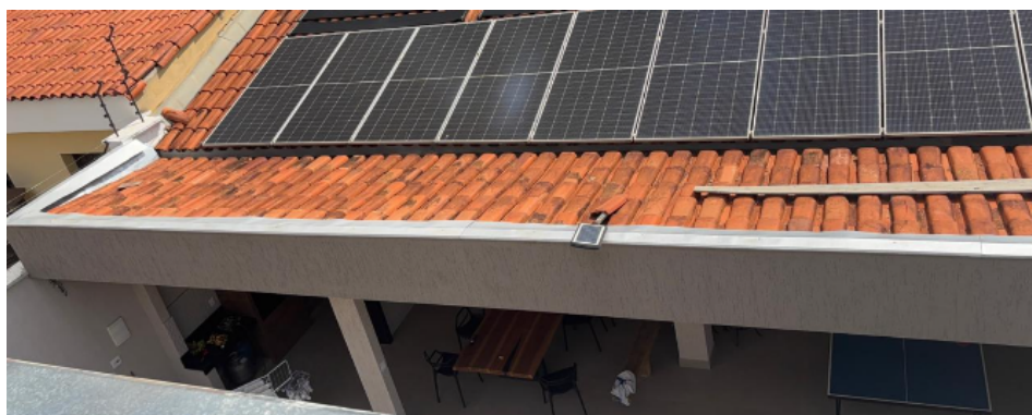
Figura 09 - Telhado reinstalado sobre a laje da área A5
