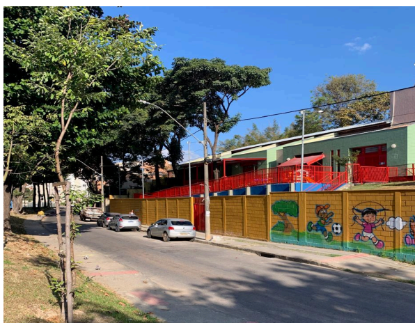
Fig. 08 - Trecho da Av. Nossa Senhora da Piedade próximo à EMEI Aarão Reis. Fonte: Suplan, 2024
