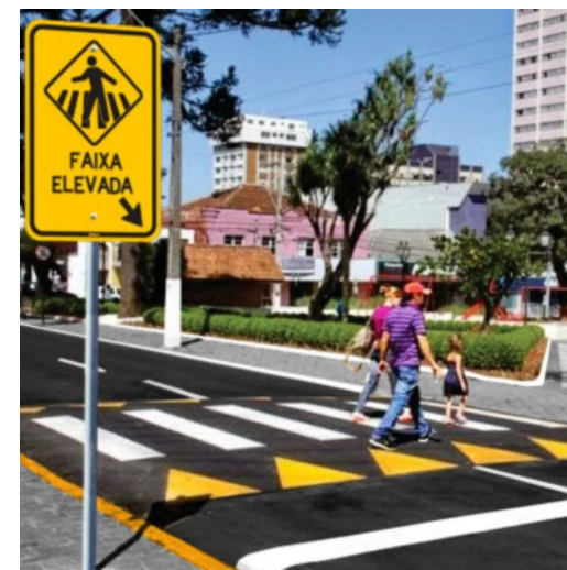
Rua com faixas elevadas para pedestres (faixa de pedestre no mesmo nível que o passeio)
