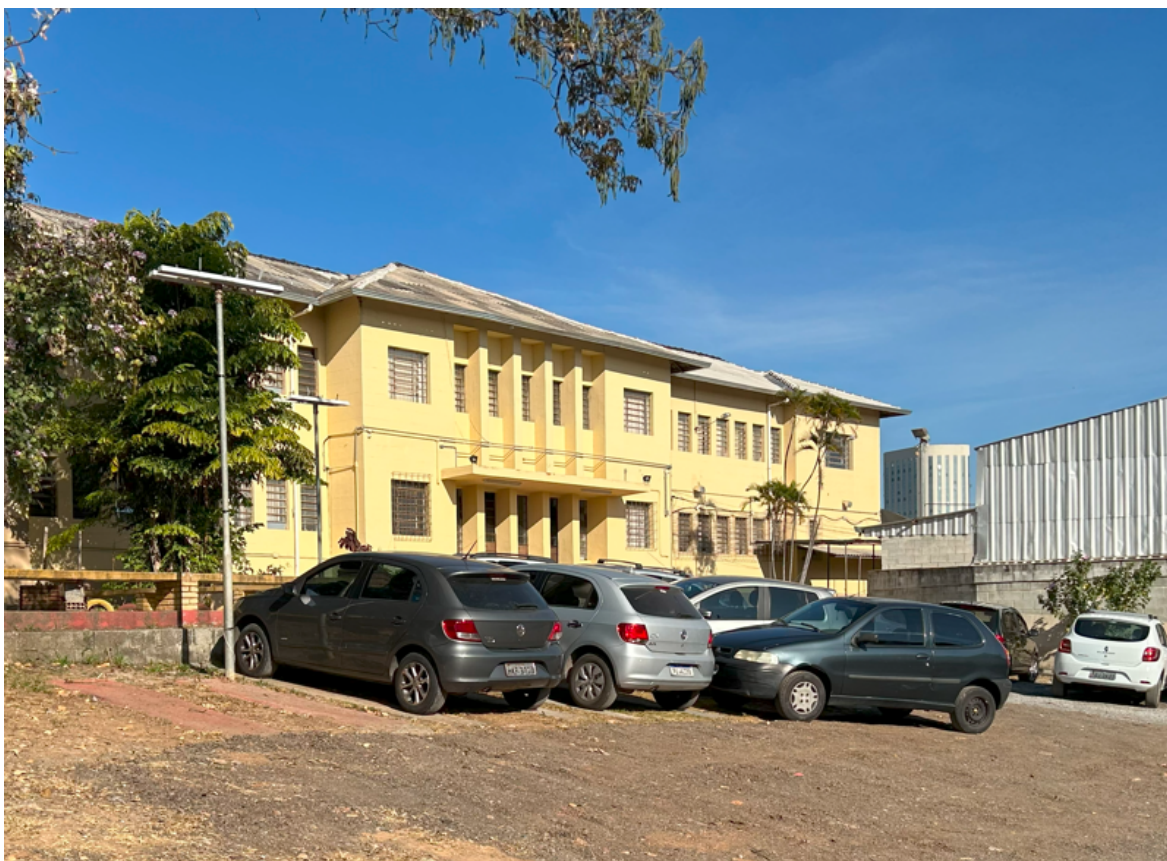
Fig. 13 - Edificação da E.M. Francisco Bressane de Azevedo, vista do acesso pela rua Maria Pietra Machado, nº 100. Fonte: PBH/SMPU/Suplan ago/2023
