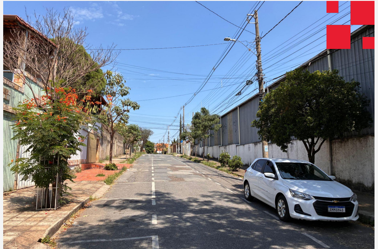
Vista geral do trecho da via em estudo, olhando em direção à Rua Teófilo Dias.
