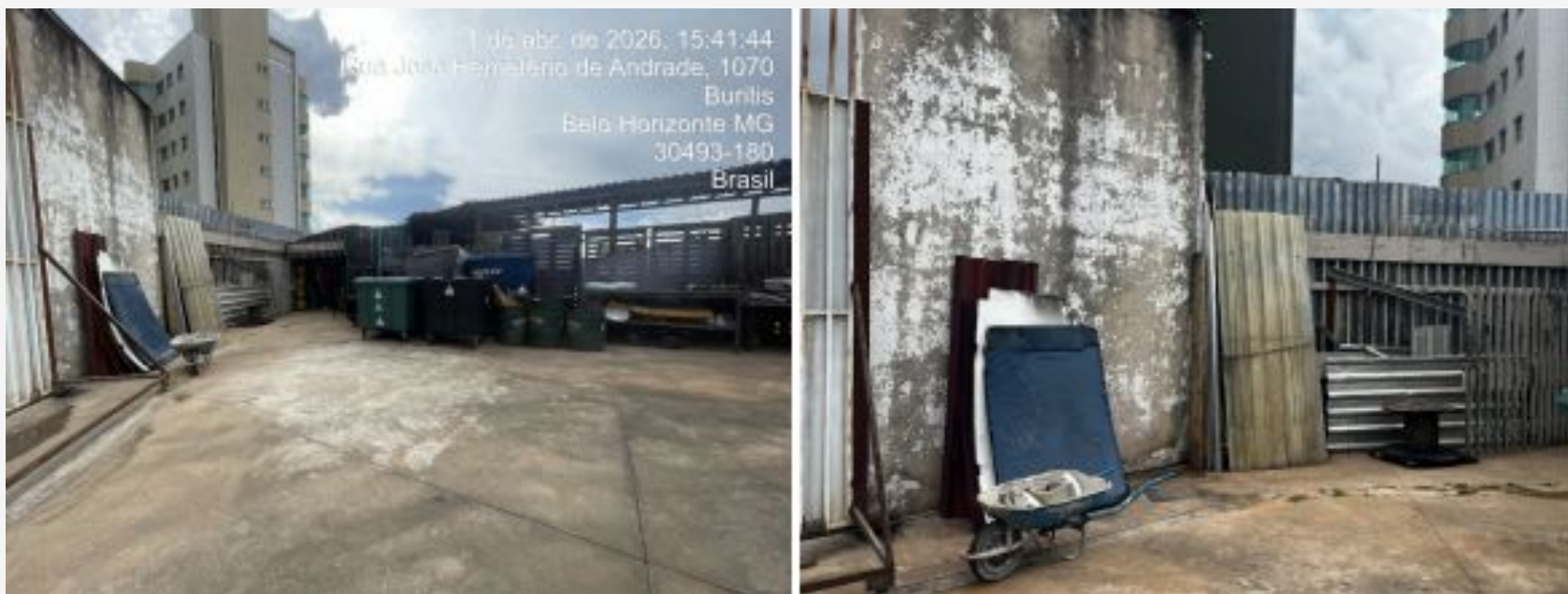
Organização e remoção de sucatas realizada conforme solicitação da Fiscalização. Fonte: Relatório fiscal do dia 01/04/2026.
