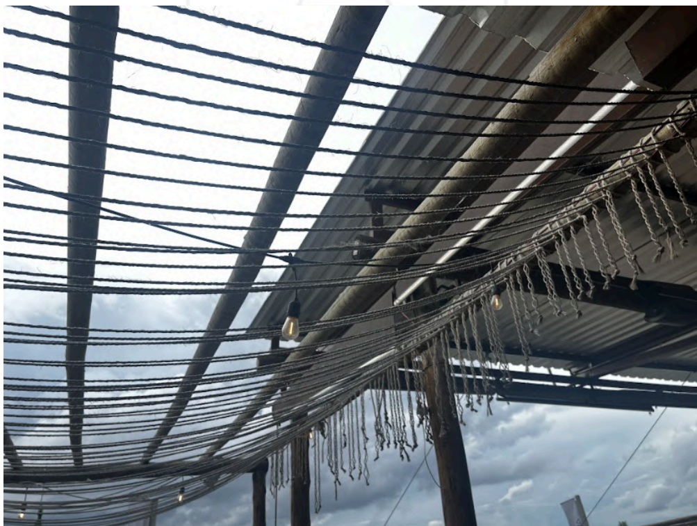
Local parcialmente coberto, com aberturas laterais. Fonte: DO AUTOR, 2026.
