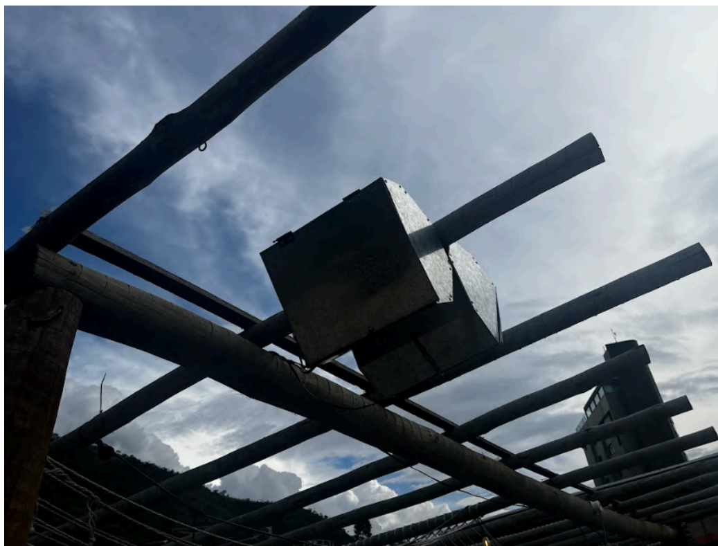
Sistema de som: caixas aéreas de sobrepor. As externas estão enclausuradas. Fonte: DO AUTOR, 2026.
