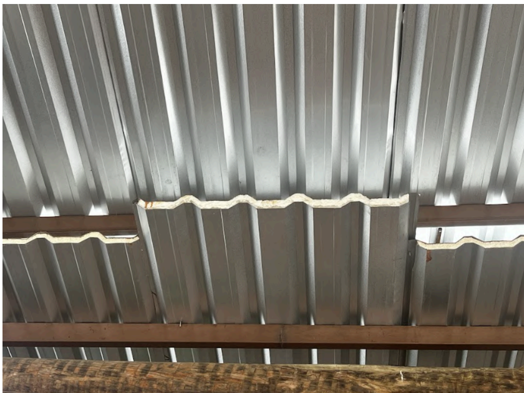
Cobertura em telha metálica termoacústica. Fonte: DO AUTOR, 2026.
