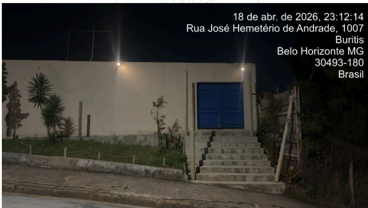
Após às 23h, o estabelecimento já havia encerrado suas atividades. Fonte: DO AUTOR, 2026.
