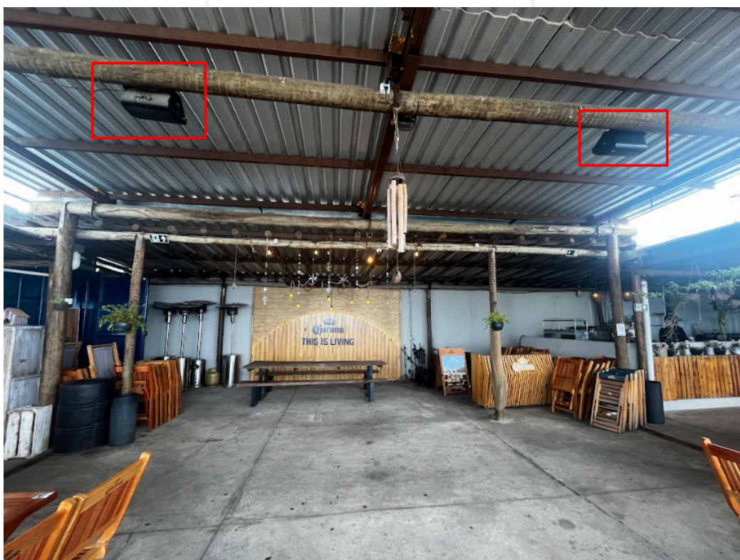
Sistema de som: caixas aéreas de sobrepor. Fonte: DO AUTOR, 2026.
