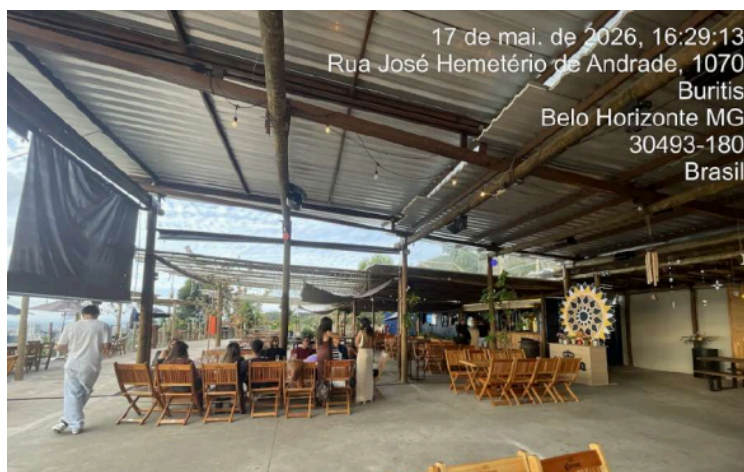
Vistoria realizada no dia 17/05/2026, durante o evento “Samba no Picco”. Fonte: Relatório fiscal.
