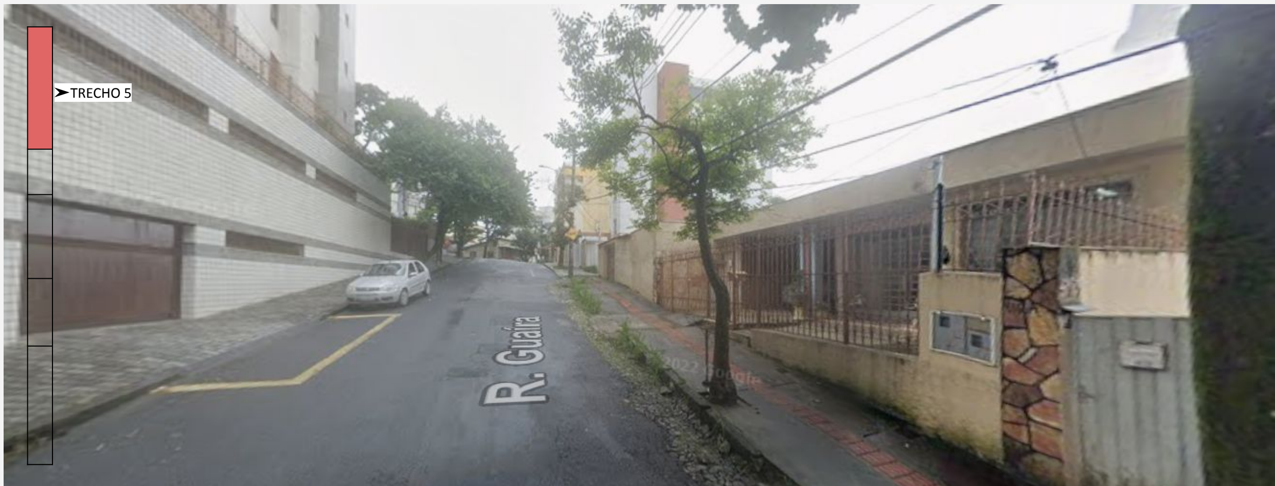
TRECHO 5 - Usos residenciais na Rua Guaíra entre ruas Alexandre Siqueira e Agostinho Bretas
