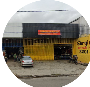
Alta presença de Galpões (1.183)
