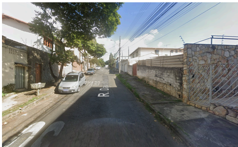
Imagem 09 - Registro fotográfico da Rua David Alves do Vale (trecho entre Rua Elza Moreira Lopes e Rua Olga Dias de Castro)
