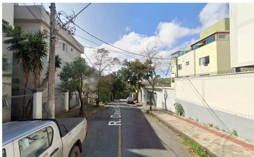
Imagem 12 - Registro fotográfico da Rua David Alves do Vale (trecho entre Rua Quintino Bocaiuva e Rua Jose de Melo)
