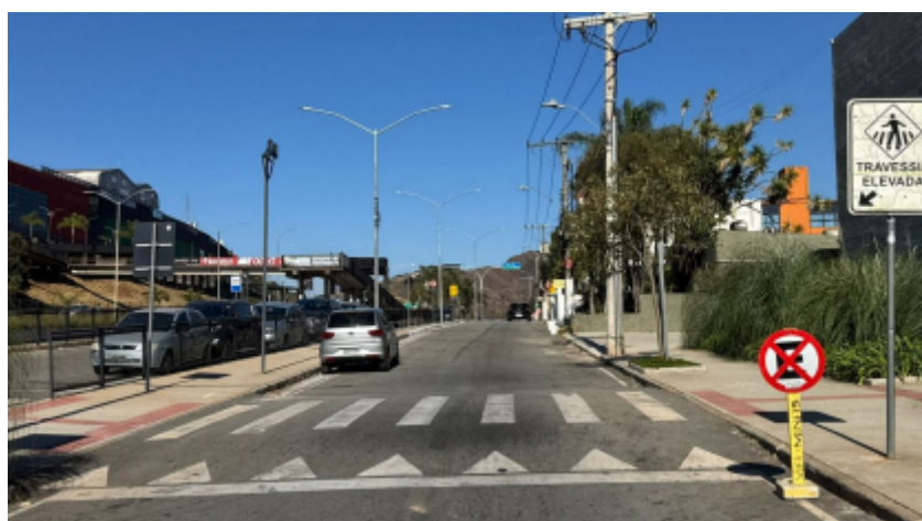
Detalhe da travessia elevada para pedestres
