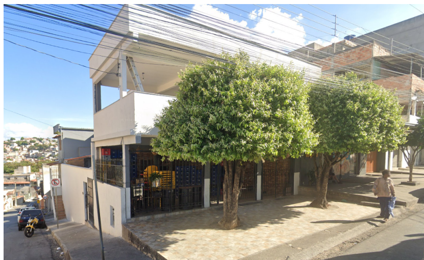
Imagem 04 - Registro fotográfico do imóvel solicitante
