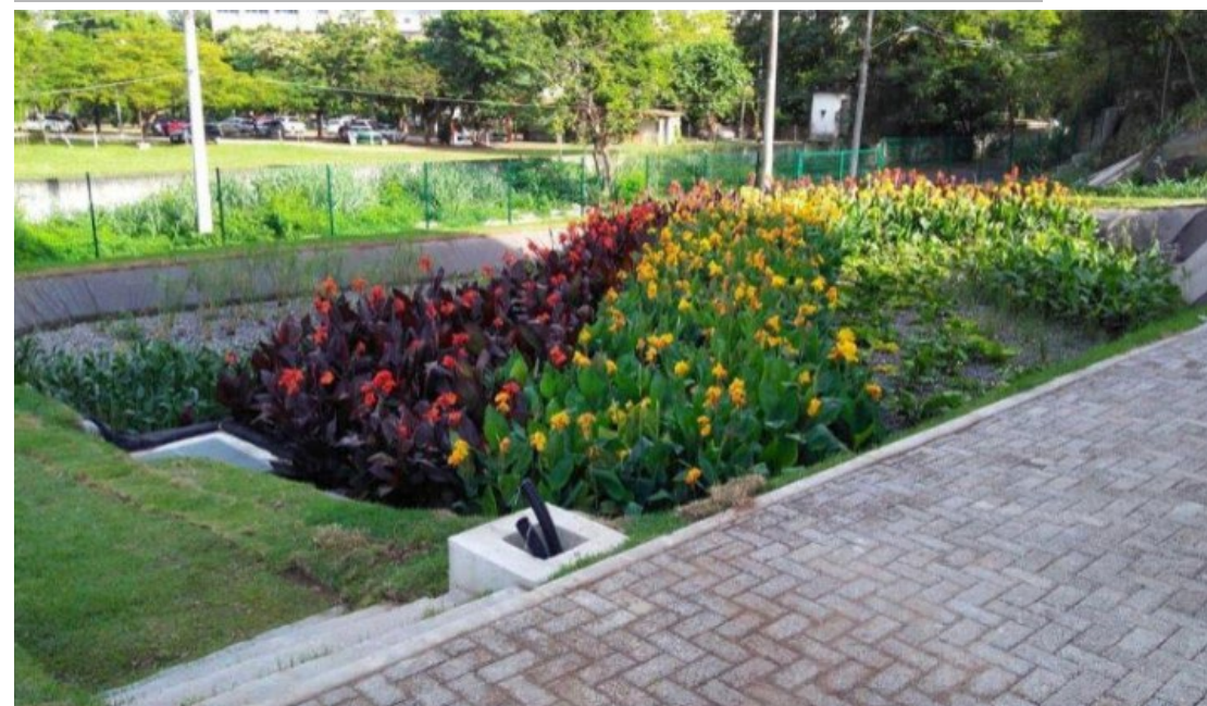
Jardim de chuva para captação das águas das chuvas do telhado. Fonte: Mendes, 2018
