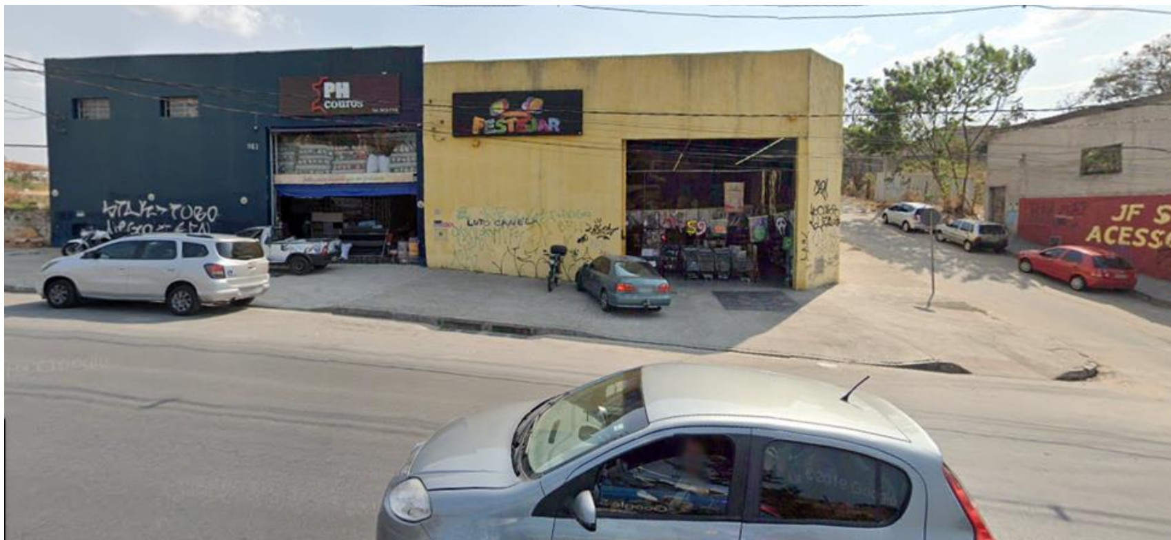
Figura 03 – Visão da fachada do lote na Av. Pres. Tancredo Neves, em 2019.
