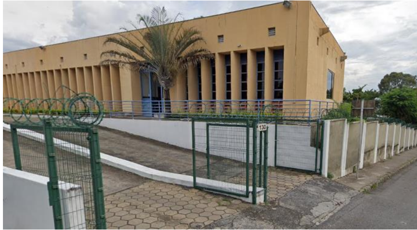
Foto 2: Trecho com grades tipo Belgo na Rua Edson da Silveira
