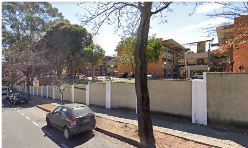
Foto 3: Trecho com desnível na Rua Walter Ianni
