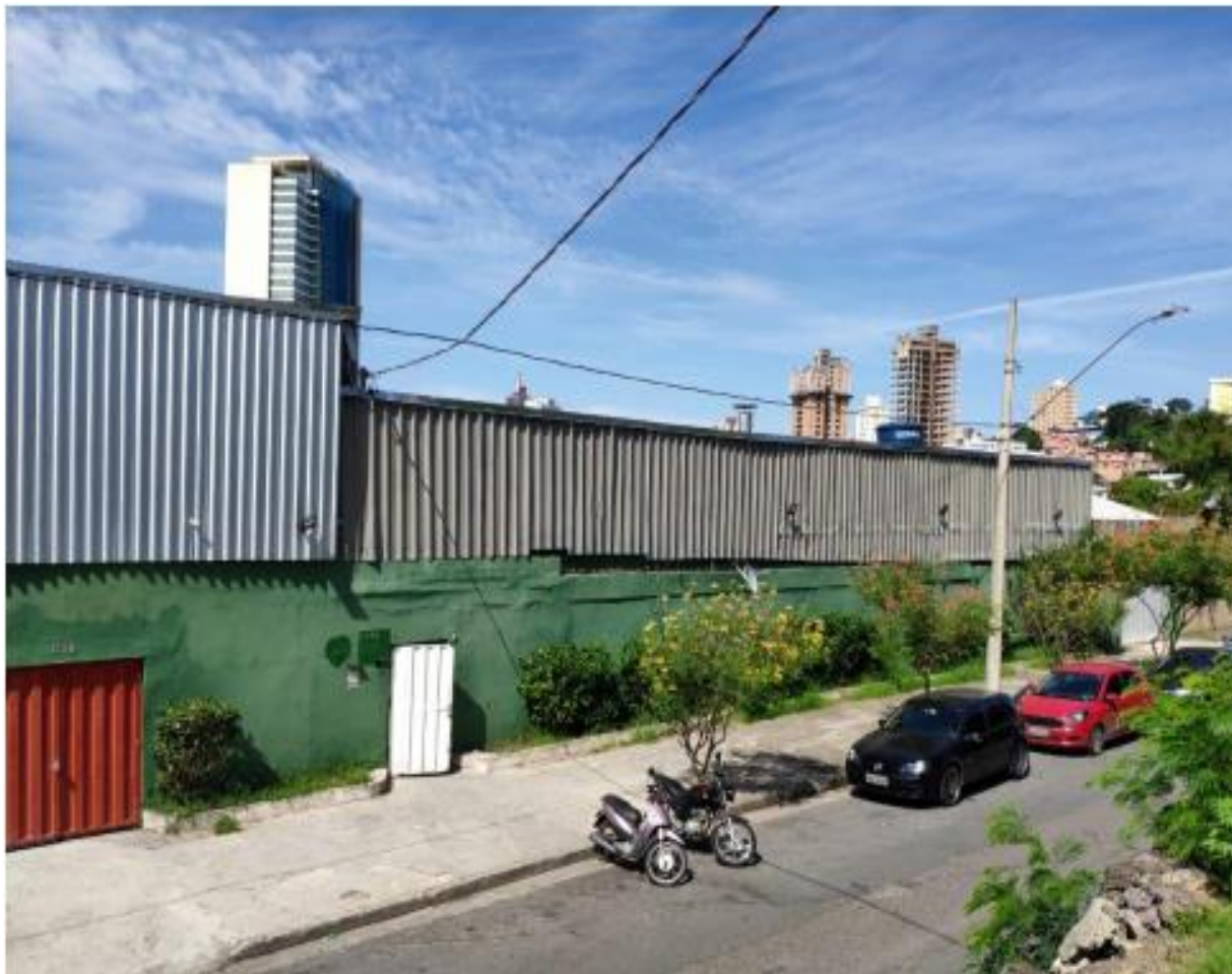
Vista da fachada do empreendimento
