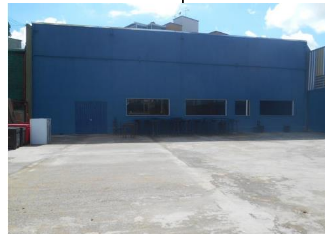
Vista área de estacionamento
