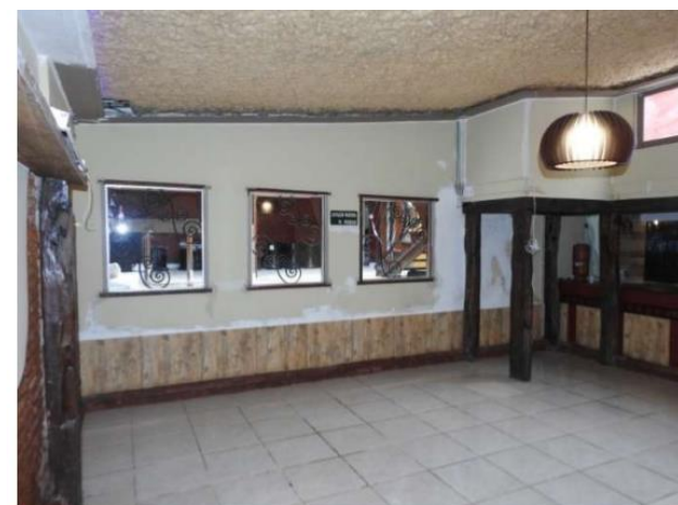
FOTO 27 – Vista da pista 01.
