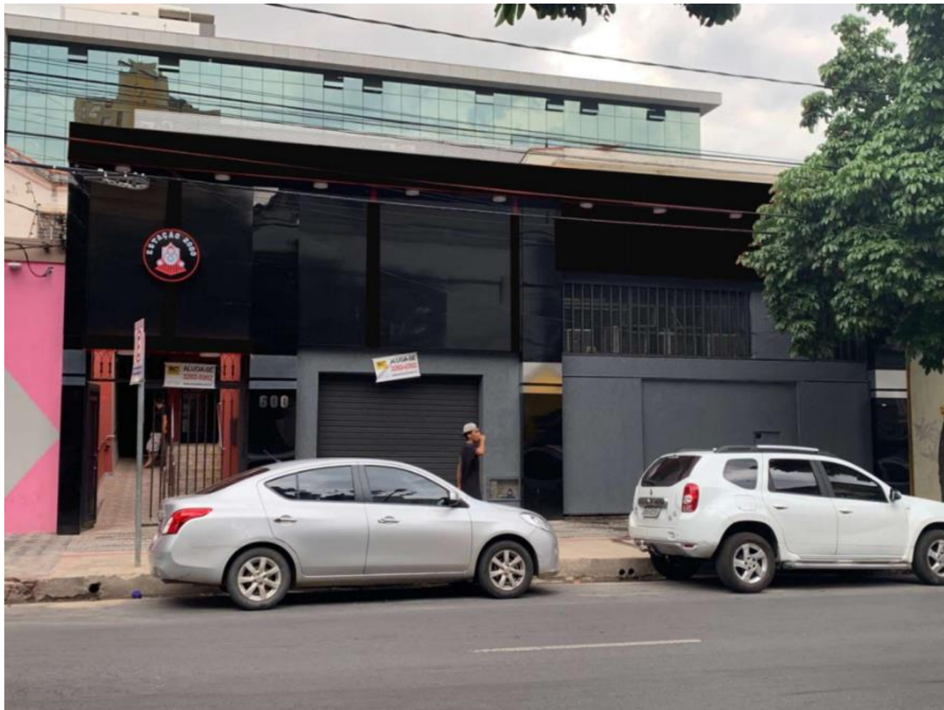
Vista da fachada do empreendimento
