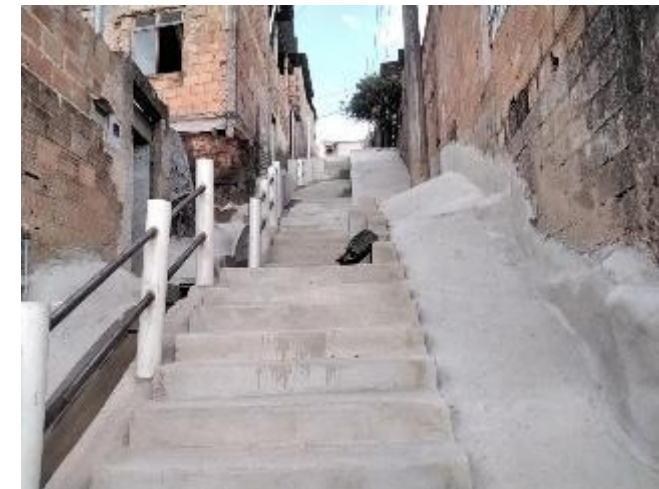
Obra de Manutenção de drenagem e execução de escadaria na Rua Santo Antônio Conjunto Taquaril – Leste
