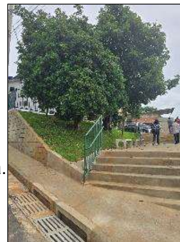
Obra Rua Vitória - Vila Nova Cachoeirinha OP 09/10
