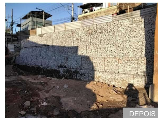
Obra de Contenção, Gabião e Arrimo R. Independência, 888 Vila Cabana do Pai Tomas – Oeste
