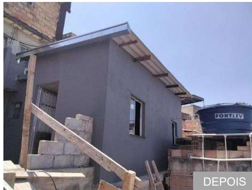
Obra de Contenção, Drenagem e Kit Moradia Beco Boa Vista, 14 – Pantanal – Oeste
