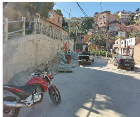
Obra de eliminação de risco geológico, muro de arrimo Rua Joaquim Pedro de Andrade Jardim Alvorada - Pampulha
