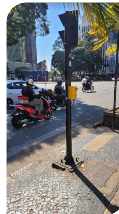
Sinal de pedestres com sonorização na Av. Afonso Pena x Av. Brasil
