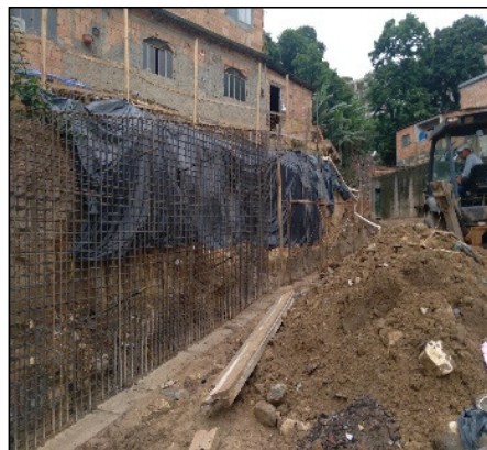
Obra de eliminação de risco geológico, muro de arrimo Rua Joaquim Pedro de Andrade Jardim Alvorada - Pampulha
