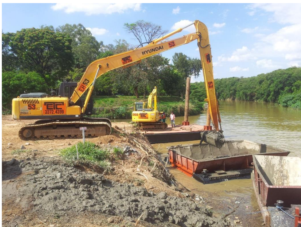
Figura 4.10 – Foto da execução dos serviços de desassoreamento (Fonte: Acervo PBH, 2020)
