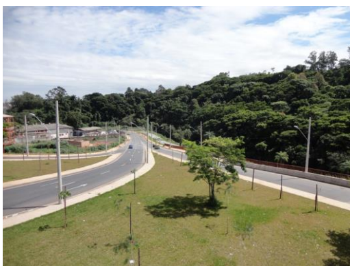
Figura 3.29 – Vista de trecho concluído da Via 210
