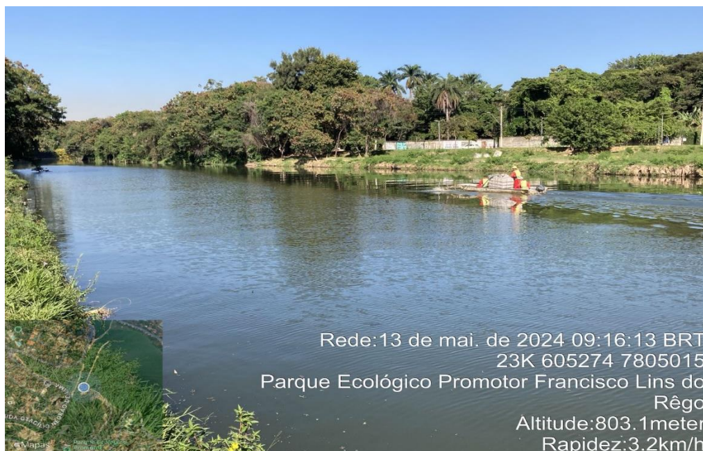
Figura 4.15 – Foto da execução dos serviços de tratamento das águas no canal da alça esquerda do Parque Ecológico (Fonte: PBH, 2024)
