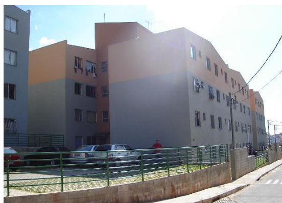
Figura 3.26 – Vista do Conjunto Habitacional R5 (obra concluída)
