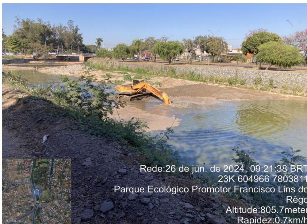
Figura 4.11 – Foto da execução dos serviços de desassoreamento no canal da alça esquerda do Parque Ecológico (Fonte: PBH, 2024)
