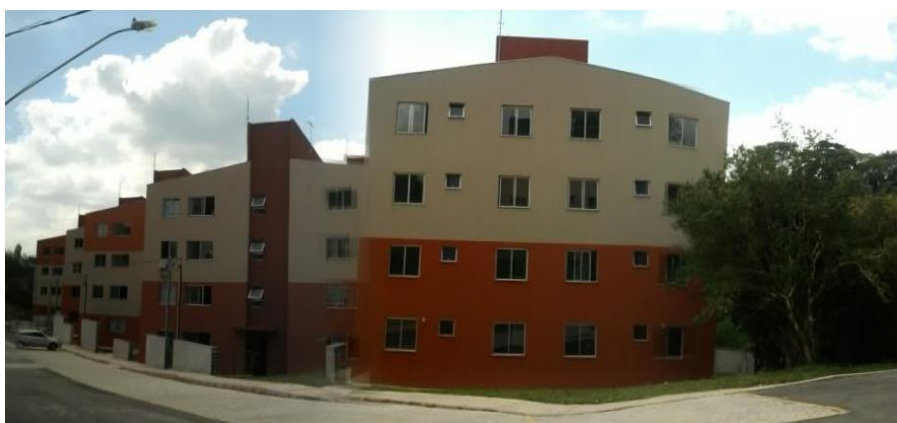
Figura 3.24 – Vista do Conjunto Habitacional R2 (obra concluída)
