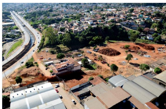
Figura 3.28 – Vista a jusante da bacia, durante a execução das obras da Via 210
