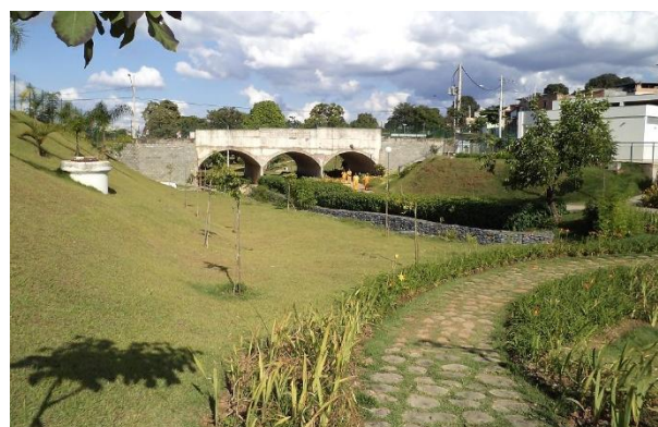
Figura 3.13 – Vista do pontilhão implantado no Parque Nossa Senhora da Piedade (obra concluída)
