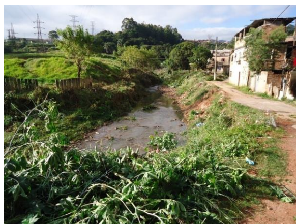
Figura 3.31 – Vista do Córrego Bonsucesso, próximo à Rua Terezinha França, antes das intervenções
