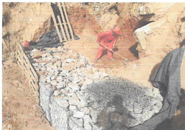
Figura 3.45 – Execução de obras na Vila Cemig / Alto das Antenas
