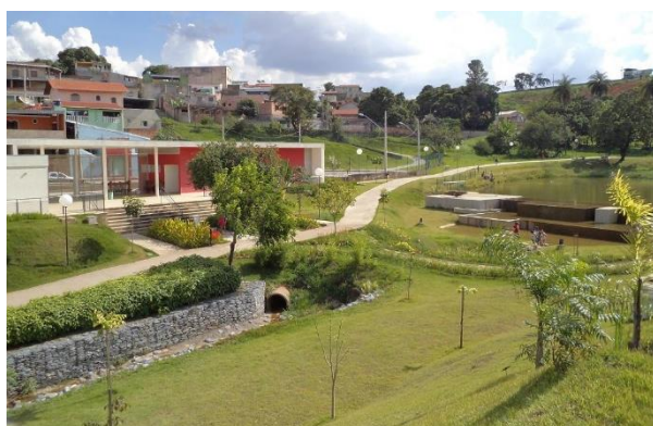
Figura 3.12 – Vista do Parque Nossa Senhora da Piedade (obra concluída)
