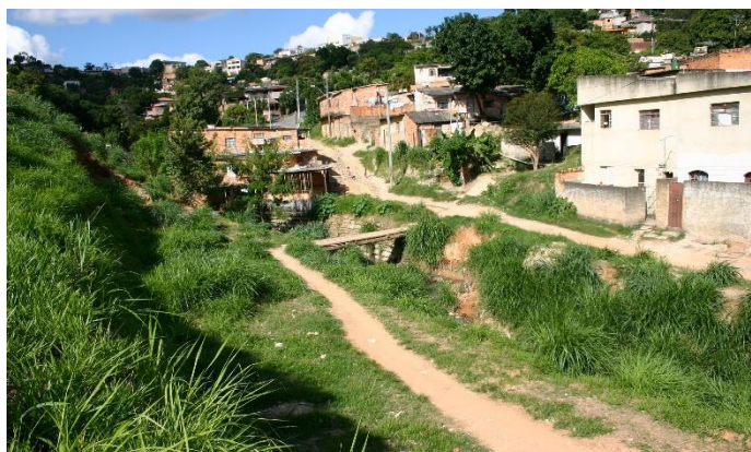
Figura 3.7 – Vista do Córrego Baleares antes das intervenções
