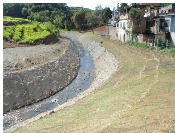
Figura 3.32 – Vista do Córrego Bonsucesso, próximo à Rua Terezinha França, após as intervenções
