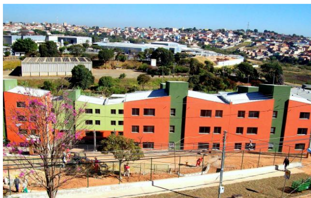
Figura 3.25 – Vista do Conjunto Habitacional R4 (obra concluída)
