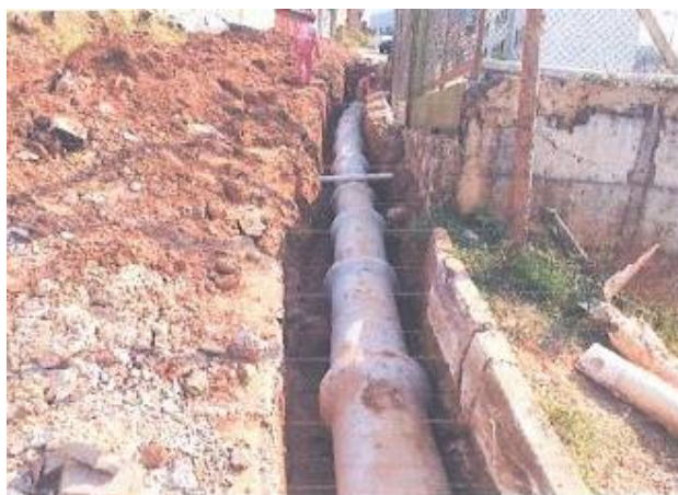
Figura 3.44 – Implantação de sistema de esgotamento sanitário na Vila Cemig / Alto das Antenas
