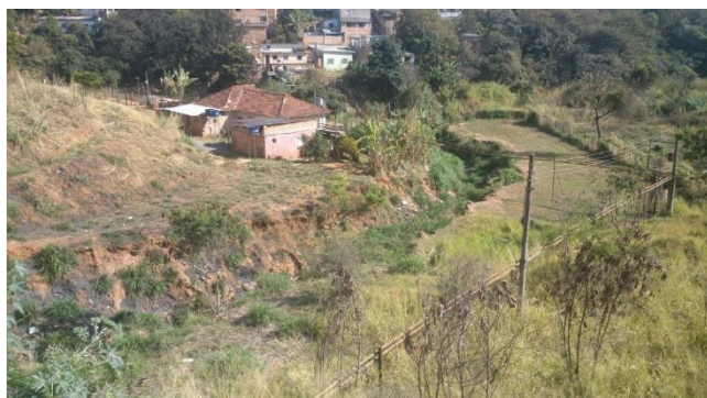
Figura 3.35 – Vista de trecho do Córrego Bonsucesso, antes das intervenções
