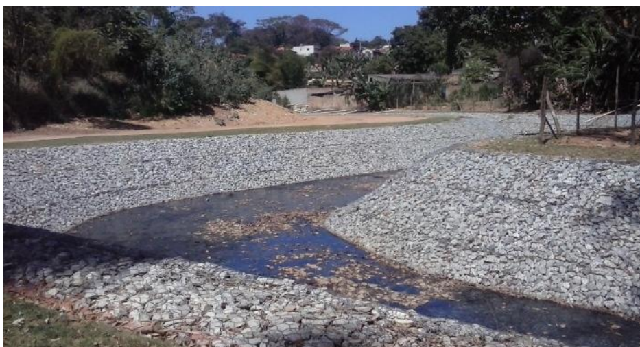
Figura 3.37 – Vista de alguns trechos do Córrego Bonsucesso, após as intervenções
