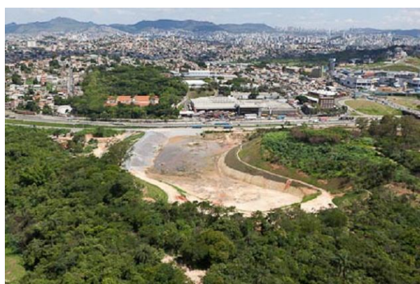
Figura 3.15 – Vista geral da bacia de retenção de cheias (obra concluída)
