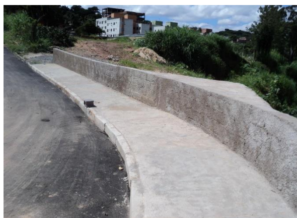
Figura 3.19 – Tratamento de erosões e contenção de taludes (obra concluída)
