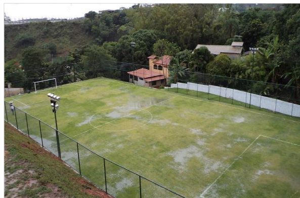
Figura 3.23– Vista do campo de futebol (obra concluída)
