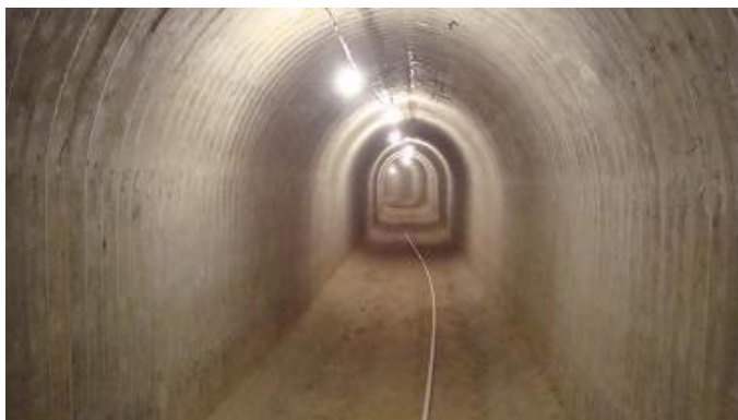
Figura 3.17 – Galeria de drenagem (túnel bala) sob o Anel Rodoviário (obra concluída)
