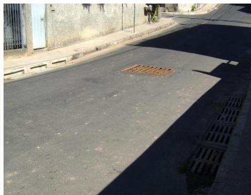
Figura 3.18 – Implantação de sistemas de drenagem pluvial (obra concluída)
