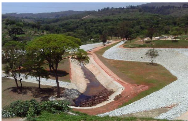
Figura 3.22 – Vista da bacia de retenção de cheias (obra concluída)
