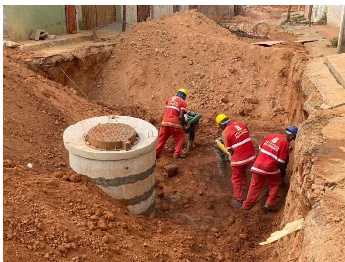
Figura 3.43 – Execução das obras de implantação de interceptores de esgotos
