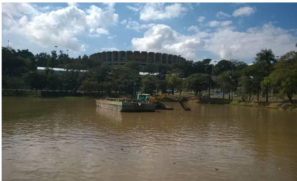
Figura 4.9 – Foto da execução dos serviços de desassoreamento (Fonte: Acervo PBH, 2014)
