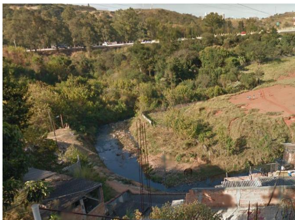
Figura 3.33 – Vista do Córrego Bonsucesso, próximo ao Anel Rodoviário, antes das intervenções
