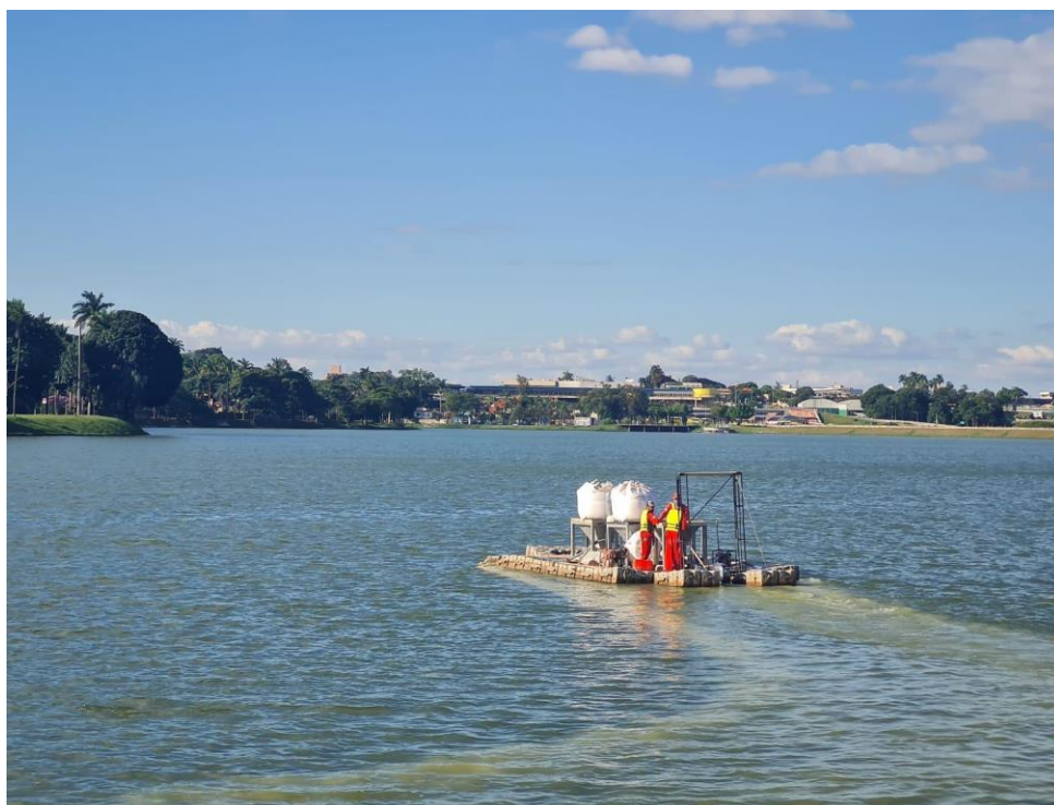
Figura 4.14 – Foto da execução dos serviços de tratamento das águas da Lagoa da Pampulha Fonte: PBH (2024)
