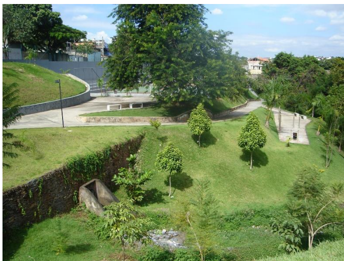
Figura 3.4 – Parque Ecológico 1º de Maio (obra concluída)
