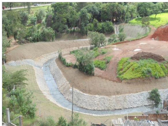
Figura 3.34 – Vista do Córrego Bonsucesso, próximo ao Anel Rodoviário, após as intervenções
