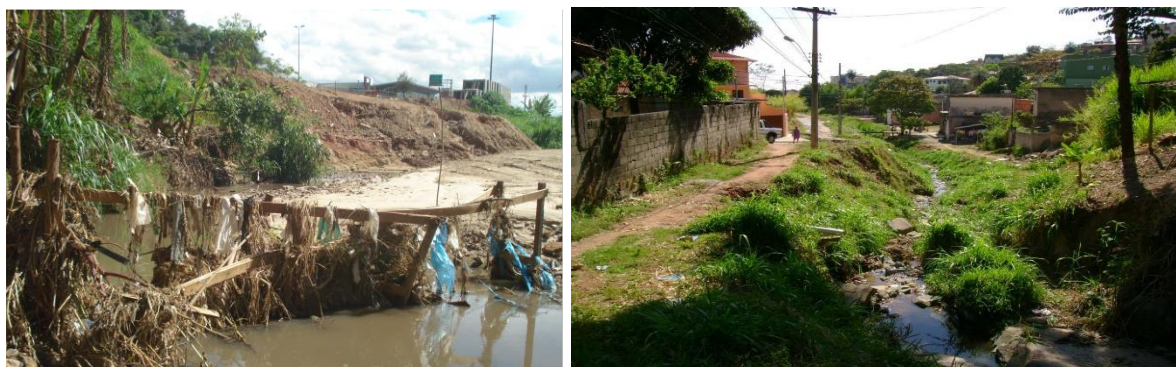
Figura 3.14 – Vista do Córrego Engenho Nogueira antes das intervenções
