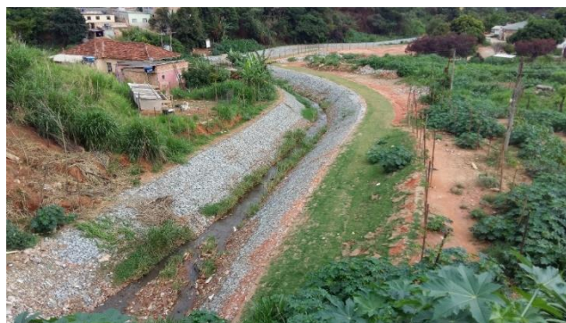
Figura 3.36 – Vista de trecho do Córrego Bonsucesso, após as intervenções
