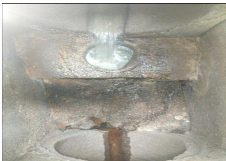
Figura 3 – Exemplo de caixas para coleta de efluentes em períodos secos (STA).
