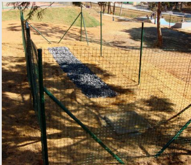
Trincheira de Infiltração Parque Nossa Senhora da Piedade e Caixa de Captação Escola Anne Frank
