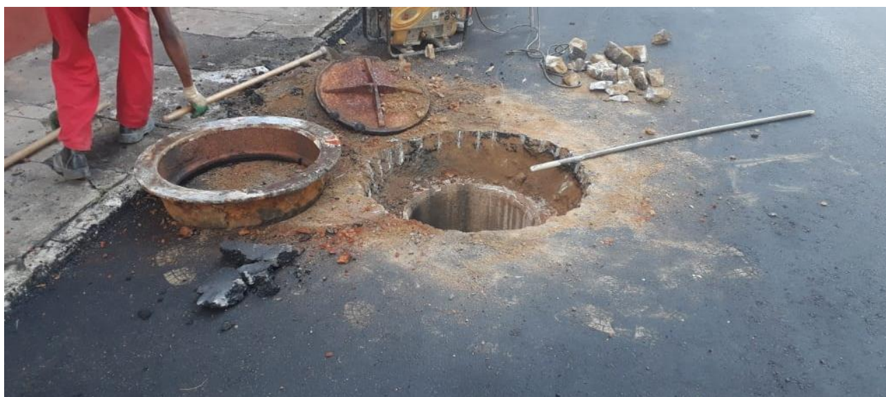
Figura 37 - Retirada do aro e tampa do poço de visita para alteamento. Fonte: Elaboração própria.
