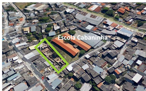
Figura 11 - Foto aérea do mesmo local já em processo de ocupação
