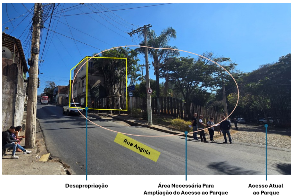
Figura 38 – Foto com situação atual do acesso ao Parque pela rua Angola
