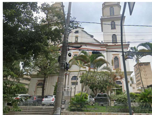
Figura 45 - Igreja de São Sebastião - Av. Augusto de Lima.
