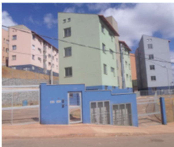
Figura 13 - Unidades habitacionais implantadas para o reassentamento de famílias removidas em função de execução de obras (Fonte: URBEL)
