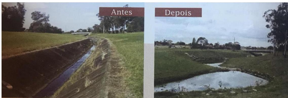
**Figura 5 - Exemplo de Restauração das Condições Naturais (Fonte: Canholi, 2015)**
