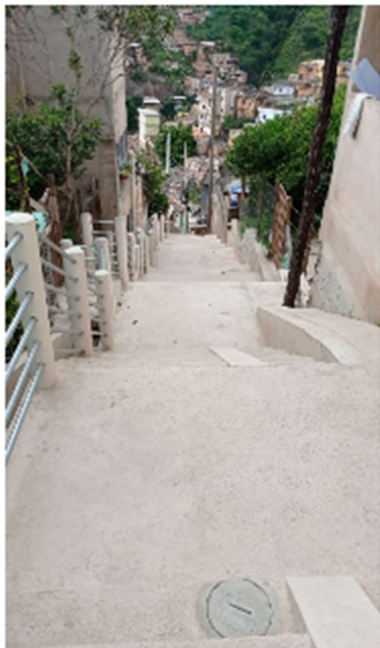
Fotos Rua Industrial - finalizada
