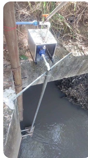
Bomba Periférica e captação com Válvula de Pé com Crivo
