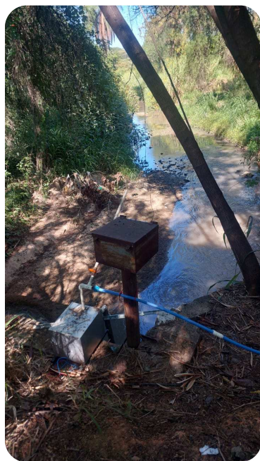
Bomba Periférica e captação com Válvula de Pé com Crivo
