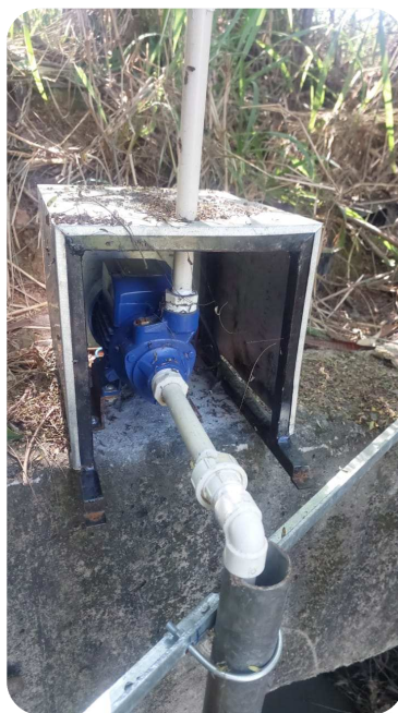
Bomba Periférica e captação com Válvula de Pé com Crivo
