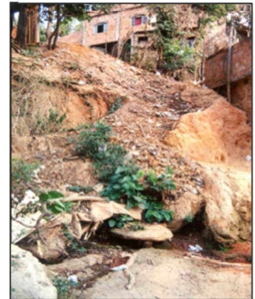
Erosão do Solo
