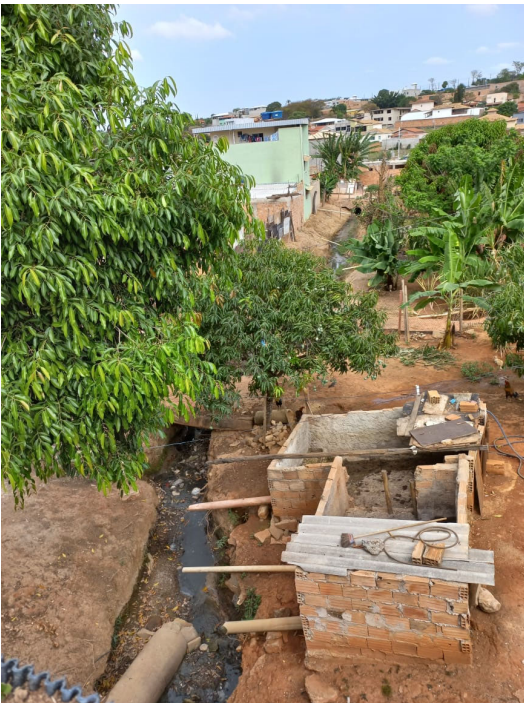
Bacia do Córrego Olhos d'Água
