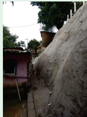
Fundo de Vale Morro das Pedras
