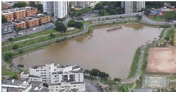
Barragem Sta. Lúcia
