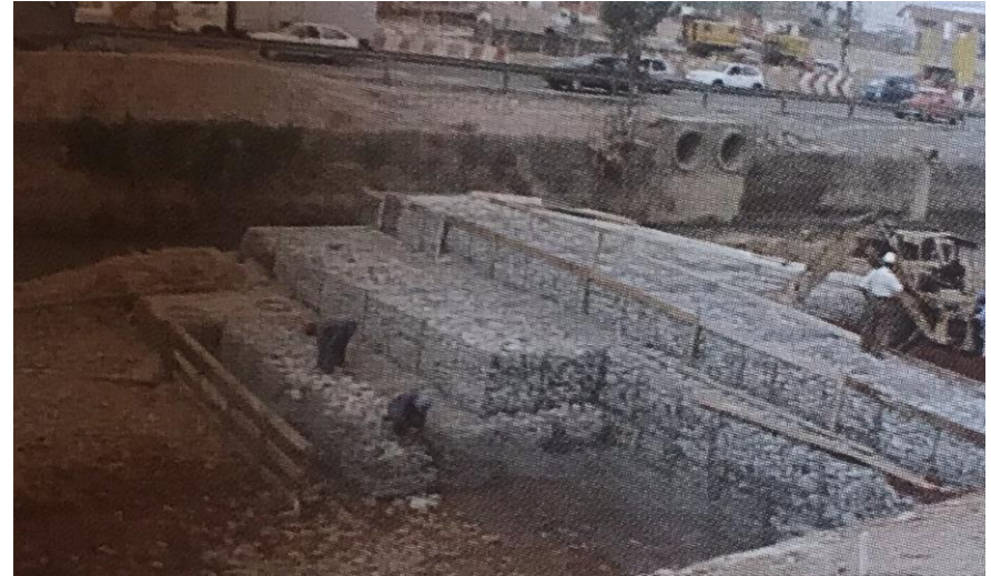
Soleiras em Execução (Gabião Caixa) – Rio Aricanduva (SP)
