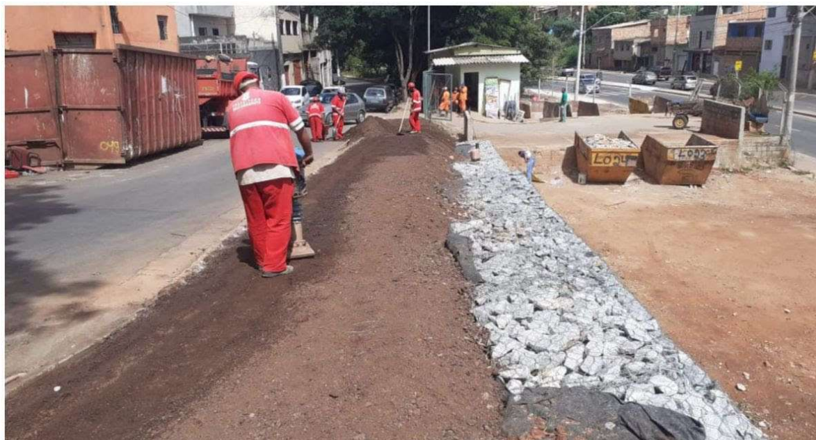
URPVs - Reforma e Adequação
