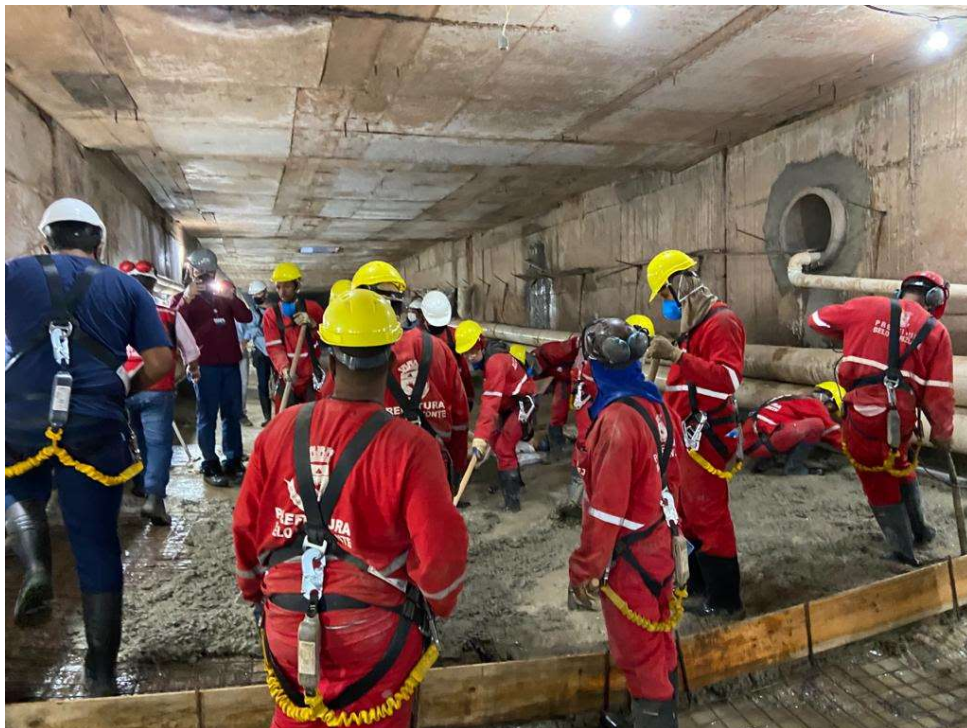
Recuperação estrutural da galeria do Córrego Leitão – Av. Prudente de Moraes
