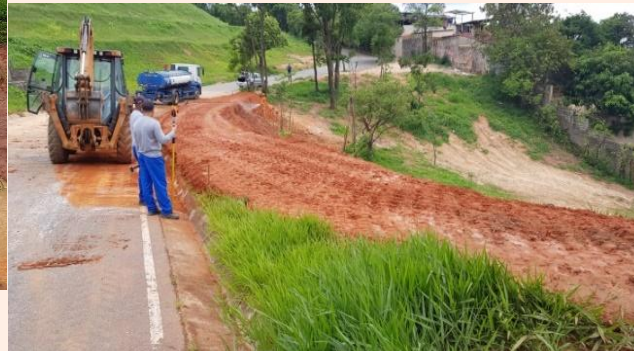
Desobstrução de rede de drenagem pluvial e construção de dique de retenção
