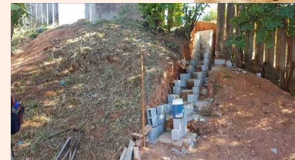
Desobstrução de rede de drenagem pluvial e construção de dique de retenção
