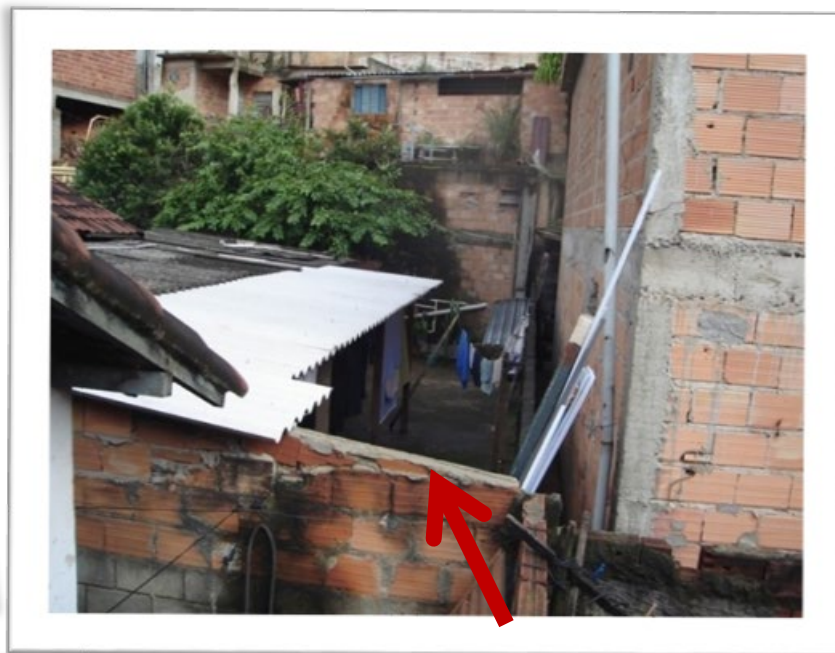
Rota de fuga: fundo da casa - sobre muros
