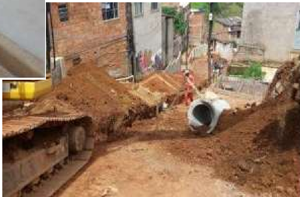
Implantação de rede de drenagem – Vila Alto Vera Cruz
