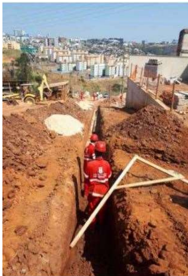
Implantação de rede de esgotos - Agglomerado Sta. Lúcia
