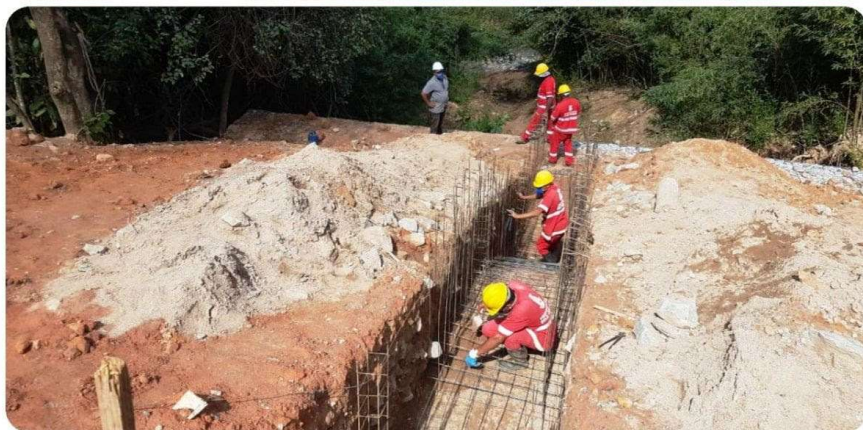
Recuperação da rede de drenagem e construção de gabião na Rua Atanásia dos Jardins - B. Jaqueline
