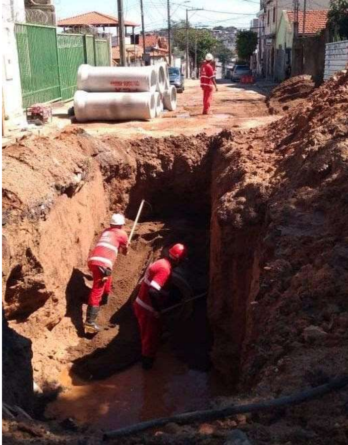
Recuperação de rede de drenagem Rua Cantagalo - B. Bom Jesus
