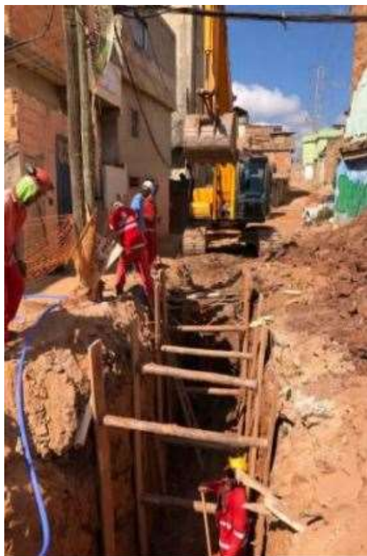
Implantação de rede de drenagem - Agglomerado Sta. Lúcia
