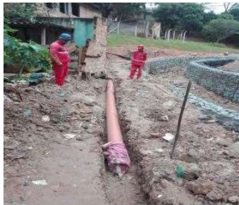
Implantação de rede de esgotos – Vila Sport Club/Glalijá
