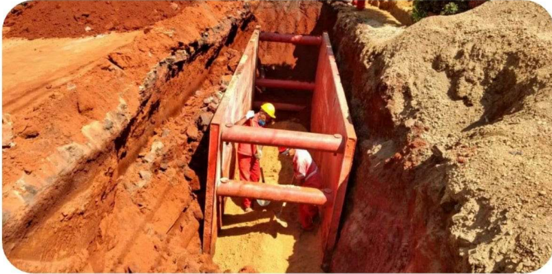
Implantação de rede de drenagem na Rua da Igualdade - B. Nova Gameleira
