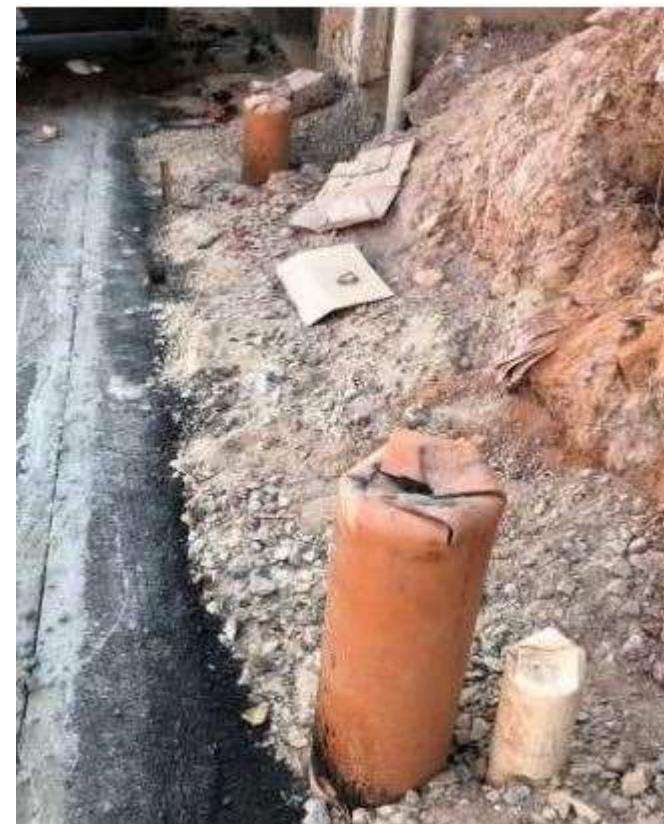
Execução de ligações prediais de esgotos - Agglomerado Sta. Lúcia
