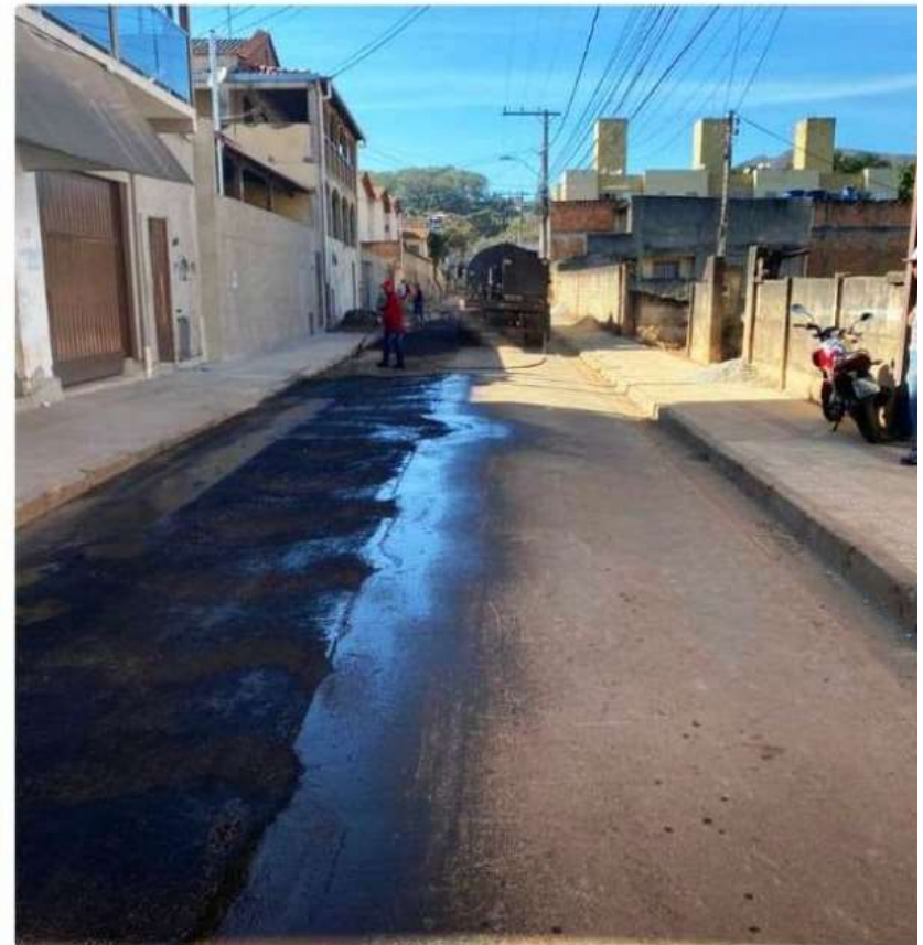
Implantação de rede de drenagem na Rua Nascimento – B. Milionários
