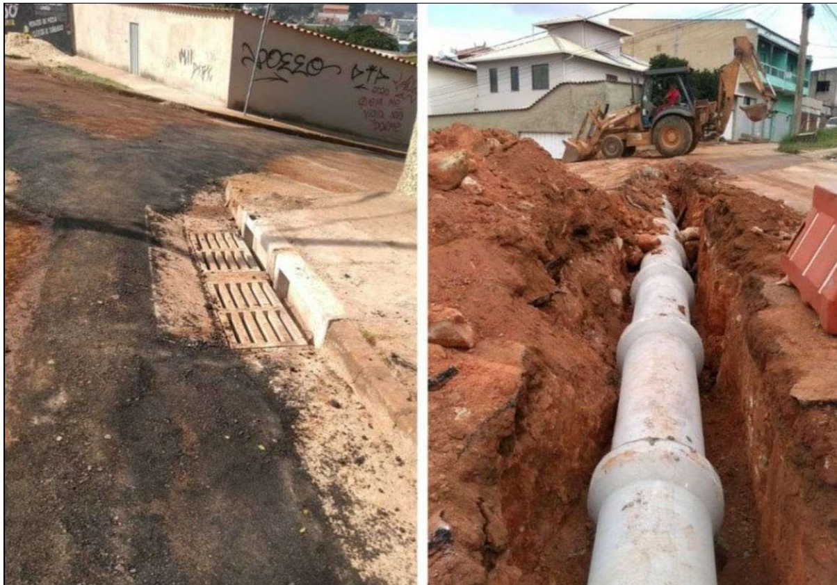
Implantação de rede de drenagem na Rua Cactus - B. Lindéia
