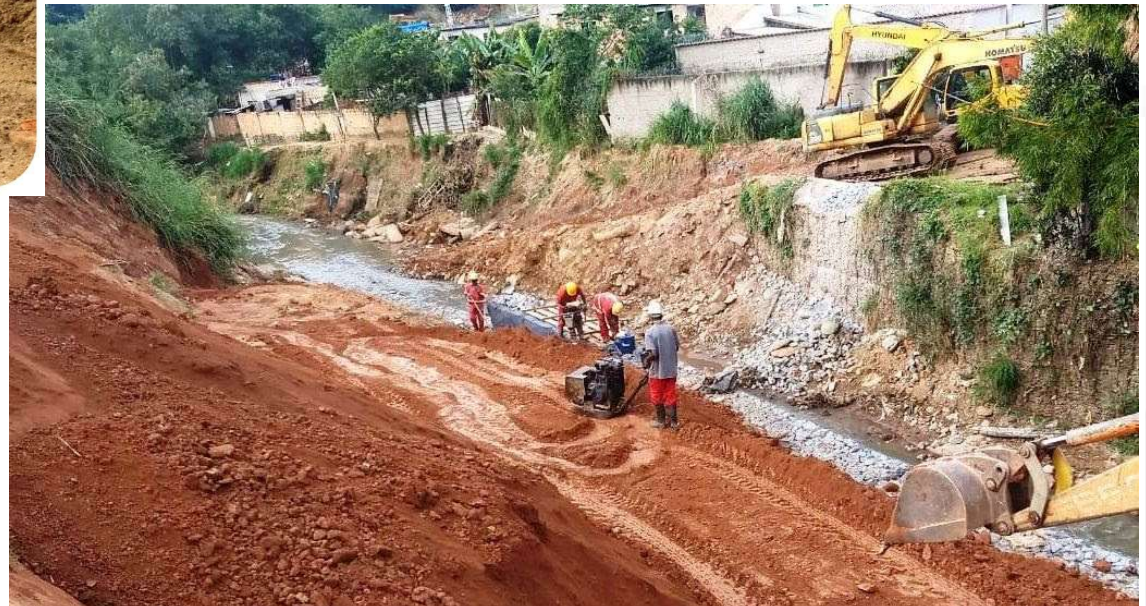
Contenção de margem do Córrego Cercadinho na Av. Walter Amadeu Pace, esq. com Rua Amendoejas – B. Marajó
