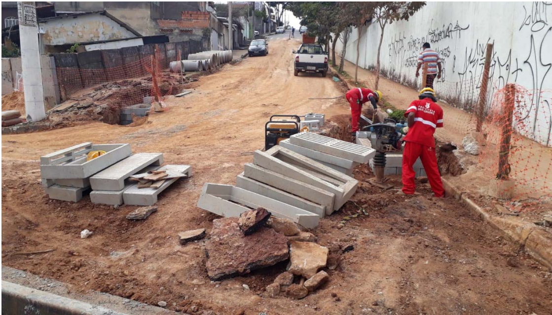
Implantação de rede de drenagem pluvial na Rua João Alexandre Pires – B. Milionários
