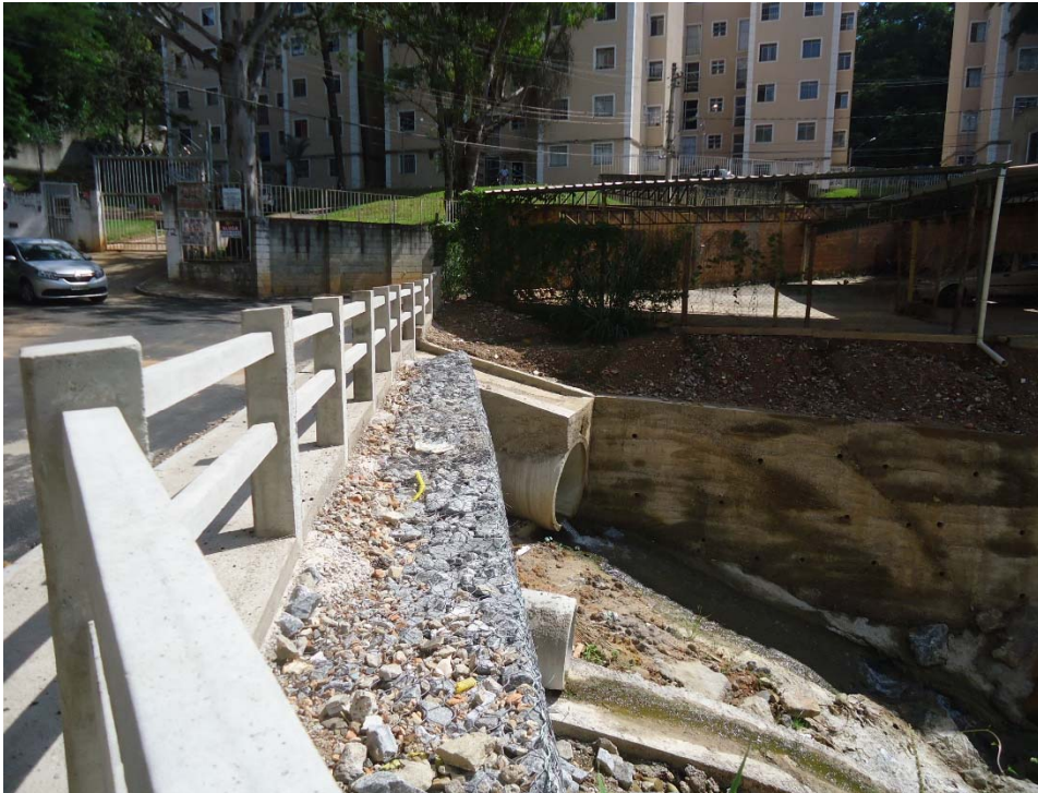
Contenção de erosão na margem de Córrego da Rua Isabel Raso – B. Jaqueline
