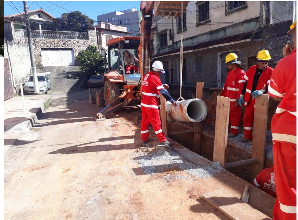
Implantação de rede de drenagem pluvial na Rua Nova Friburgo – B. Bom Jesus
