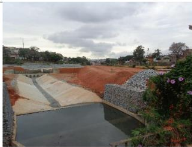
Foto 2 Obras da margem direita finalizada, esgoto é encaminhado para ETE Arrudas
