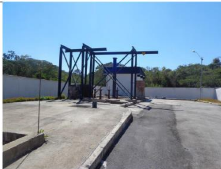
Foto 6 Vista geral da EEE Estaleiro
