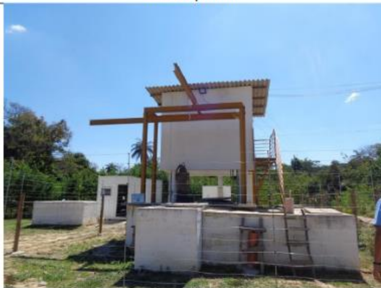
Foto 5 Vista geral da EEE Barroquinha
