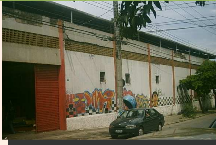
Reforma Galpão Ituiutaba R$2.341.900,00
