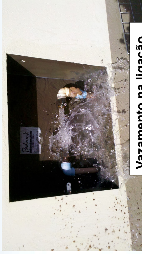
Vazamento na rede de distribuição
