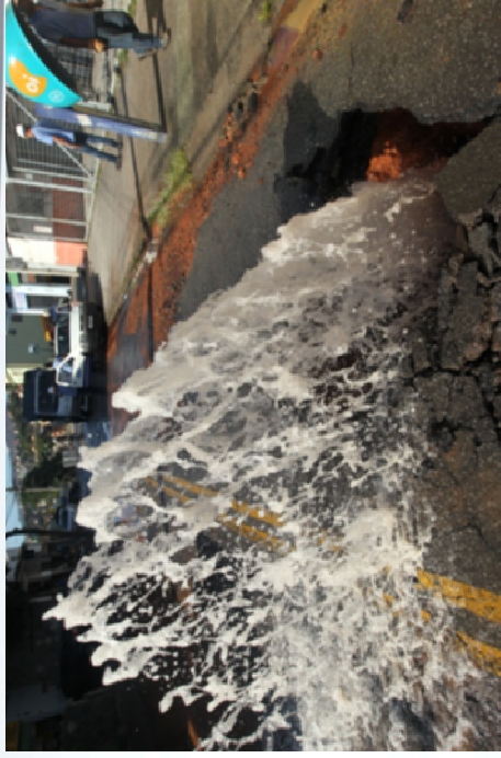
Vazamento na rede de distribuição
