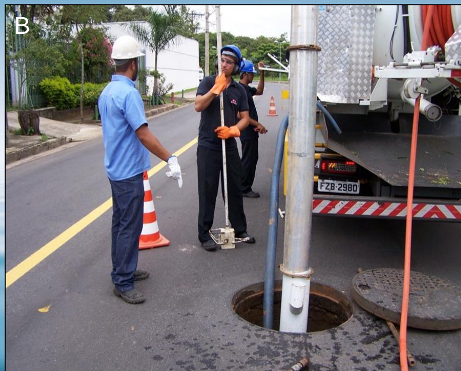
Fotos A e B: Caminhão com equipamento conjugado (Hidrojato e Sucção)
