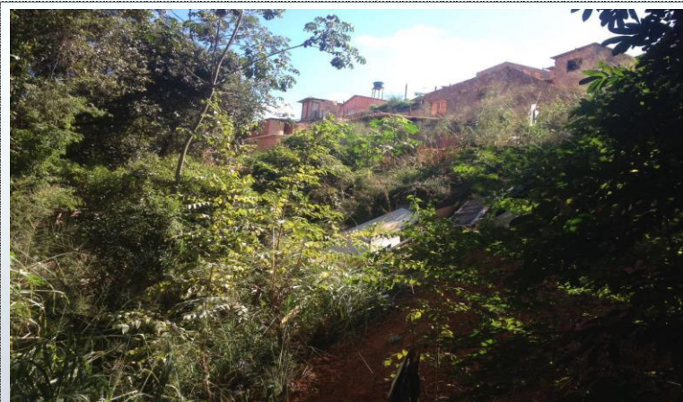
EDIFICAÇÕES EM CONTRUÇÃO EM ÁREA DE DIFÍCIL ACESSO
