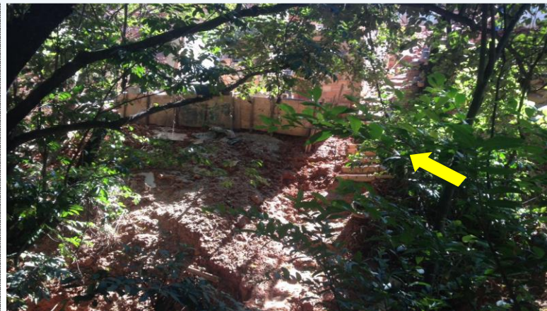
ESCADA DE ACESSO PARA AS OCUPAÇÕES
