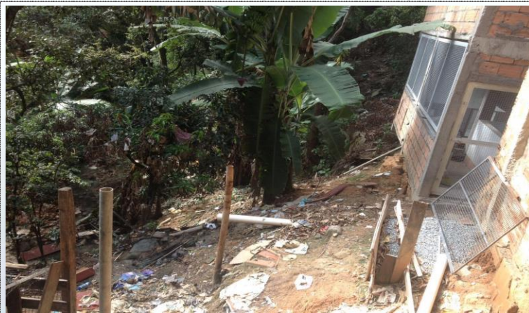
EDIFICAÇÕES EM CONTRUÇÃO EM ÁREA DE DIFÍCIL ACESSO
